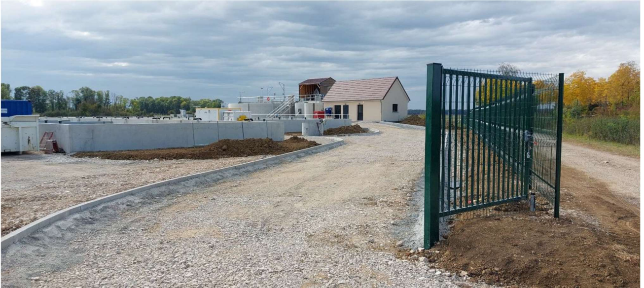
Nouvelle station d'épuration intercommunale à Montbarrey
