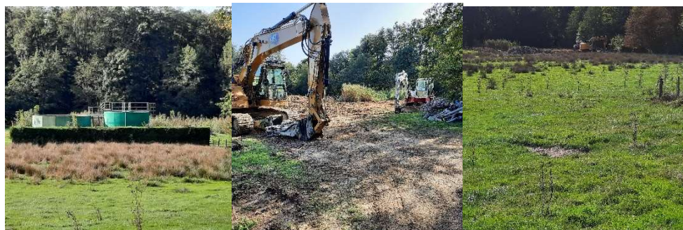
Suppression de la station d'épuration de La Vieille Loye
