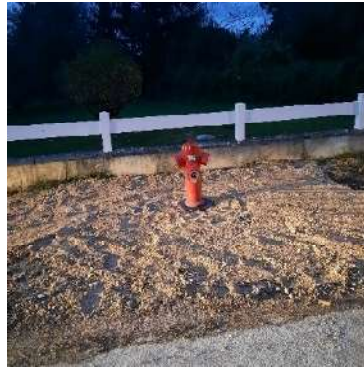
Nette amélioration de la défense incendie de notre commune.
